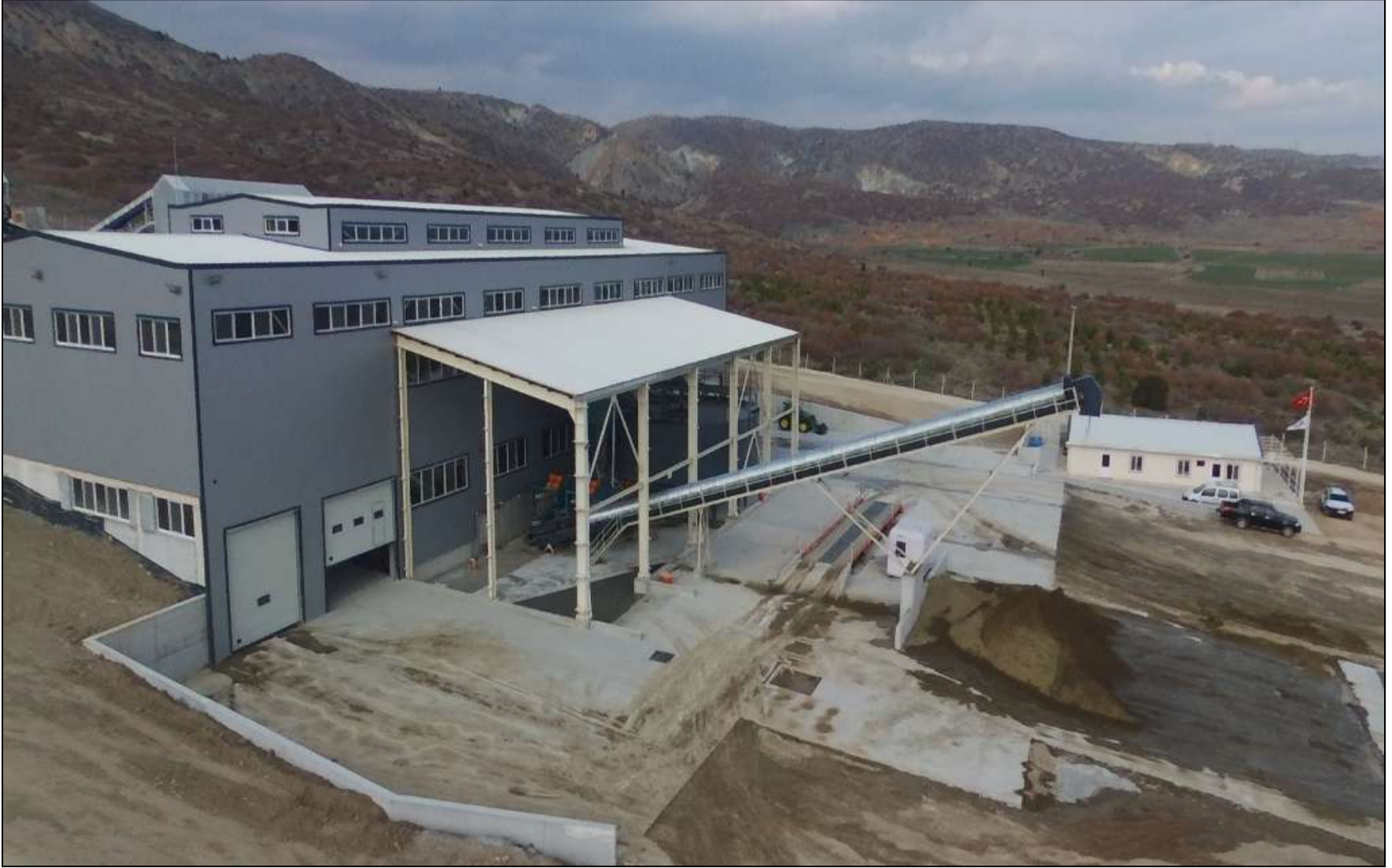
ALKİM ESKİŞEHİR KROM İŞLETMESİ Konsantre Tesisi
