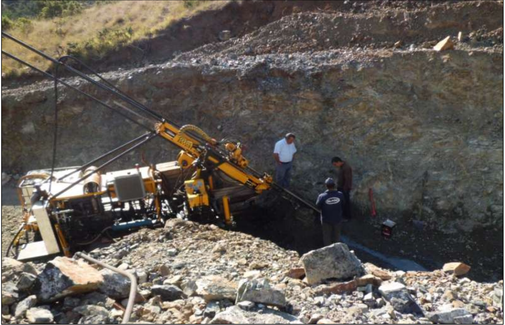
ALKİM ESKİŞEHİR KROM MADENİ Sondaj Çalışmaları
