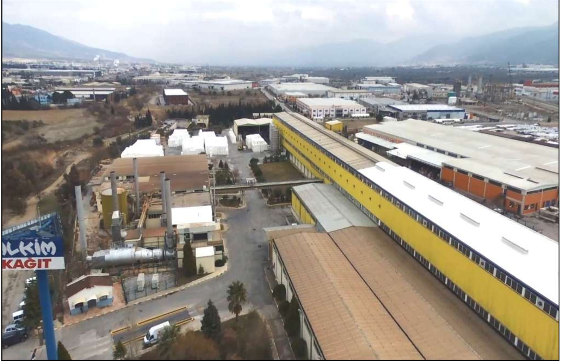
Fabrikanın Batı – Doğu istikametinde genel görünüşü
